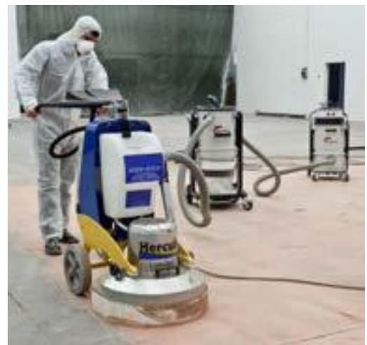
**66** Separatori mobili con scarico Longopac per trattamento superfici | *Separators with Longopac discharge system for floor preparation*
